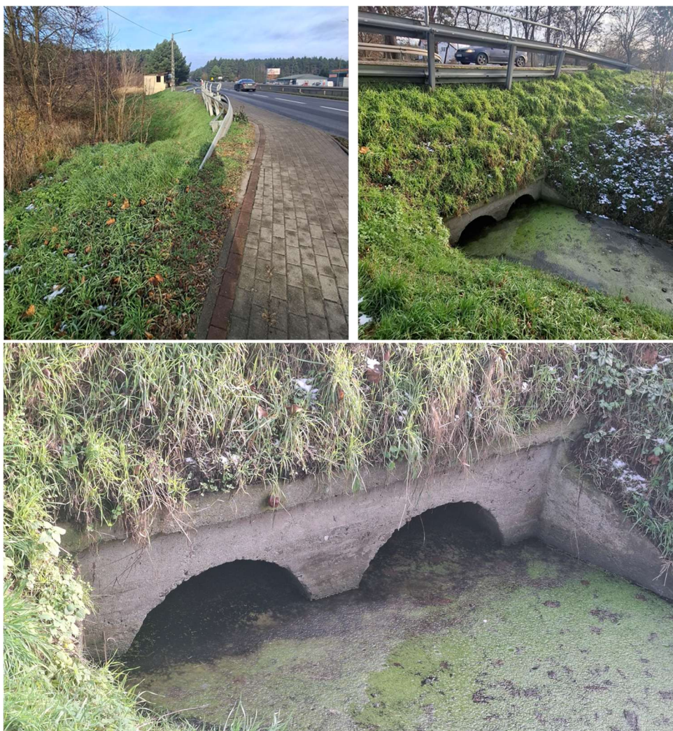
Zdj. 10-12. Istniejący przepust pod drogą DK23
