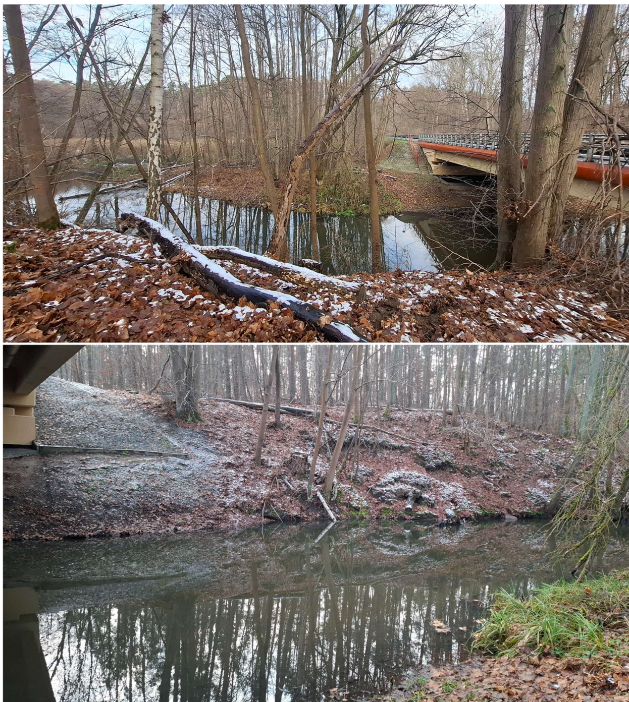
Zdj. 18-22. Istniejący obiekt mostowy nad rzeką Myślą w km. ok 1+500
