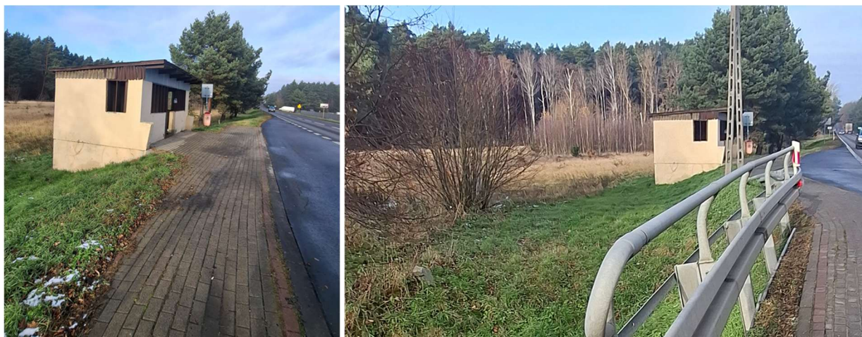
Zdj. 13-14. Istniejąca wiata przystankowa
